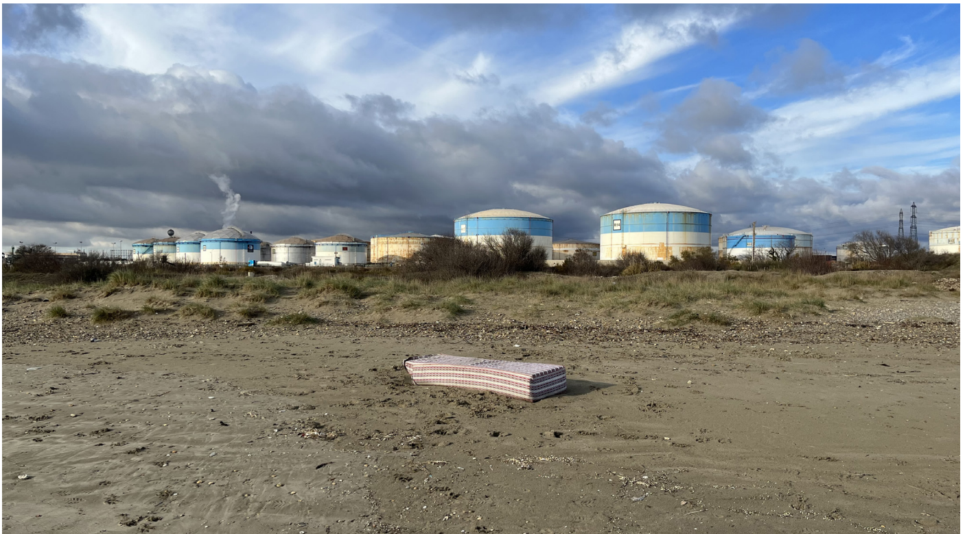
Cylindres du dépôt pétrolier depuis la plage du Cavaou
