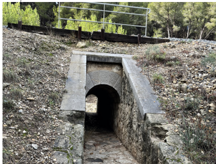
Un passage étroit sous la voie ferrée
