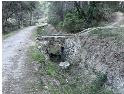
Des ouvrages en pierre conférant un caractère pittoresque au site
