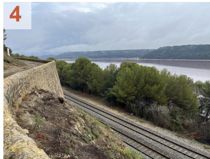
4 Un muret existant traçant un sentier à flanc du coteau ouest
