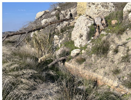
Le canal des Marigues a longer au bas de Saint-Blaise
