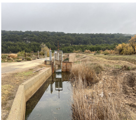
Les martelières jalonnent le site, permettant d'ouvrir ou fermer la circulation des eaux
